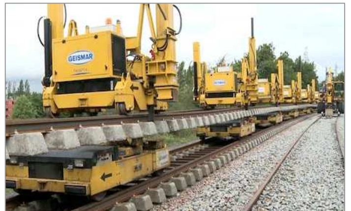
Chantier de rénovation des voies sur la ligne du tram train de Nantes à Châteaubriant d'une longueur de 62 km.
