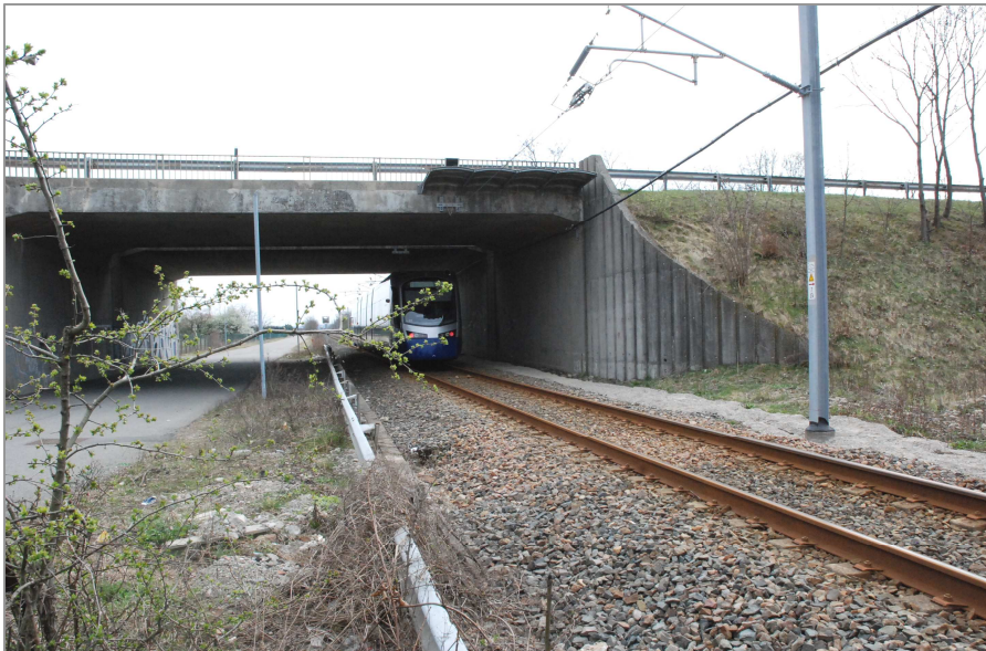
Ci-dessus le passage de la ligne Mulhouse – Thann sous la RD 83 à Cernay.
