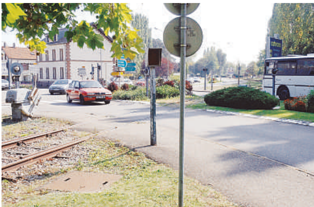
Des passages à niveau le long de la voie ferrée entre Guebwiller et Bollwiller: un point qui pourrait remettre en cause sa réouverture... (Photo DNA)
